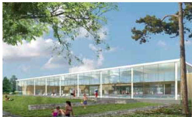
Centre Aquatique - Baud
