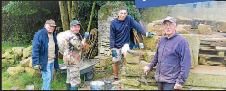
Construction du four à pain près du Trait d'Union
